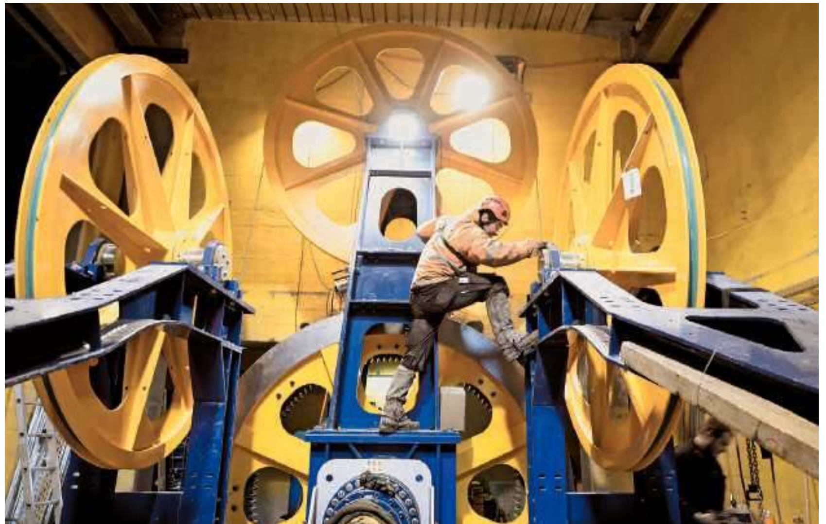
Die Wirtschaft kommt in Fahrt: Ein Monteur bei der Arbeit an der Pilatus-Seilbahn. Foto: Keystone
